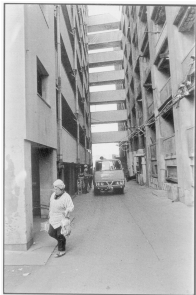
端島銀座と渡り廊下
